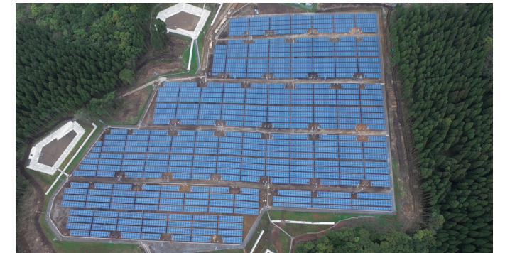
宮之浦太陽光発電所
