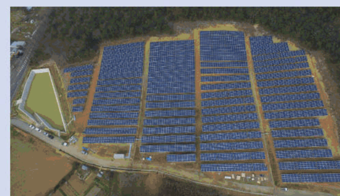
岐阜県関市発電所
