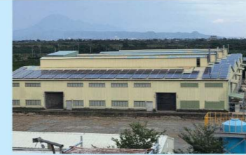
Taitung Farmhouse 702.9kW
