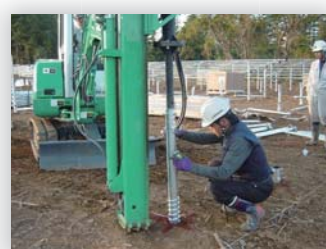
3 杭の打ち込み中間位置にて再度レベル確認。
