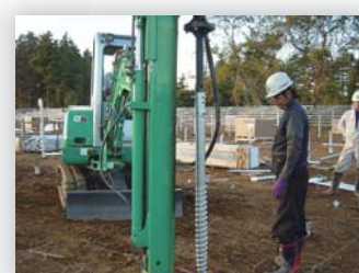
2 水平機を使用して杭のレベル確認。微調整を行ったあと、打ち込み開始。
