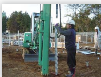
1 ドリルマストを接地し、駆動軸を杭に挿入。ピン等で固定。
