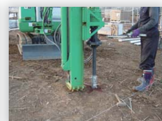
4 打ち込み完了。固定ピンを抜き駆動軸を抜き取る。
